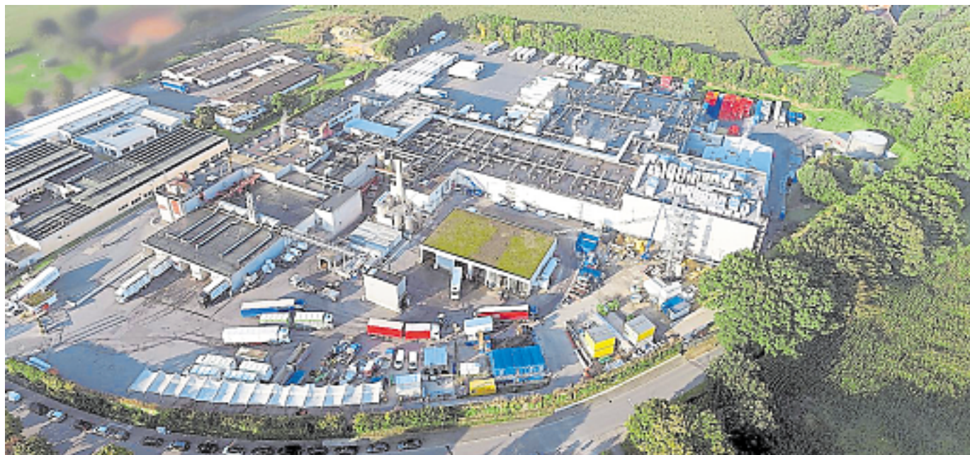
Der Westfleisch-Betrieb in Coesfeld stellt die Weichen für noch mehr Umweltschutz und Ressourcenschonung: Gezielt investiert die Genossenschaft in hochmoderne Anlagen – ganz aktuell in den Bau eines energieeffizienten Kühlhauses. Im Untergeschoss entstehen zusätzlich neue Sozialräume für die Beschäftigten.
